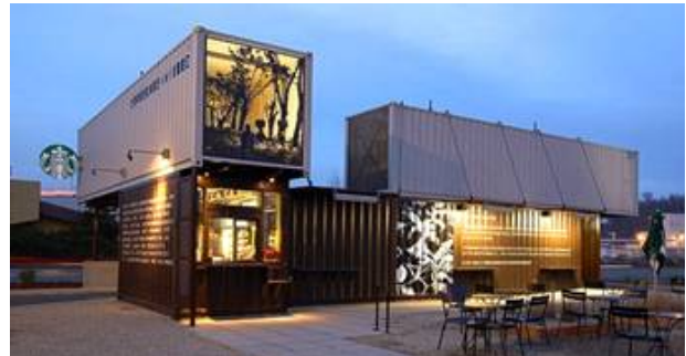
Penerapan konsep green building pada gerai kopi Starbucks
